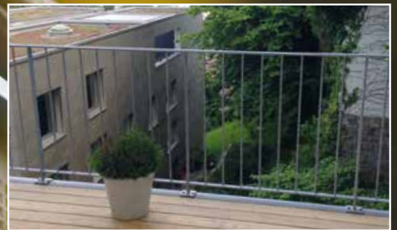
Stäbe lassen ein Geländer weniger markant wirken und somit das gesamte Erscheinungsbild des Balkons leichter.
